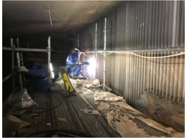
Obr. 2: Provádění nástřiku elektrickým obloukem
