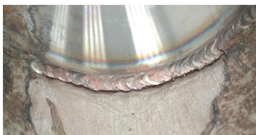
Obr. 1: Makroskopický pohled na korodovaný svarový spoj
