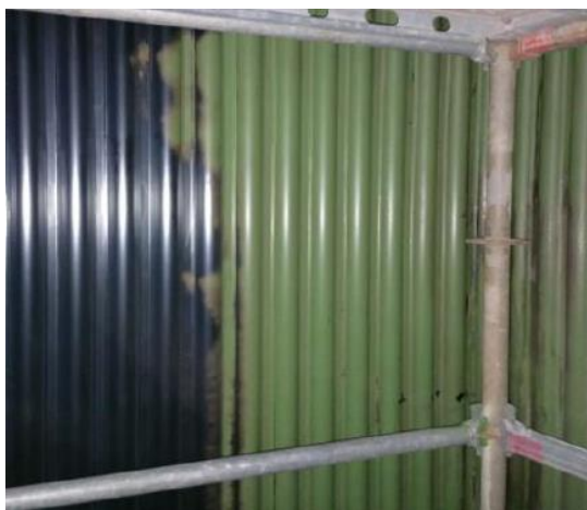
Obr. 10: Keramika po roce provozu, fluidní kotel
