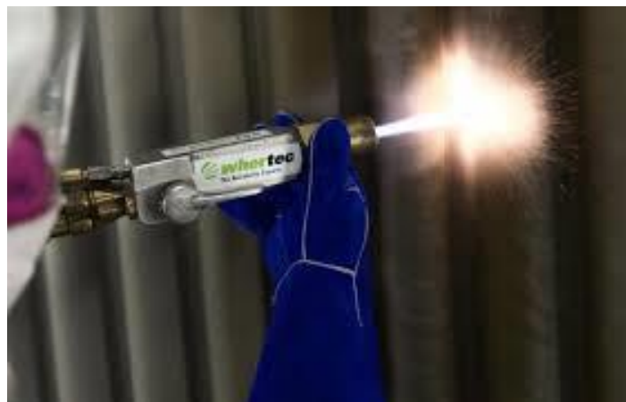
Obr. 4: Ruční HVOF hořák – nástřik membránové stěny fluidního kotle (povlak Ni + karbid chromu)
