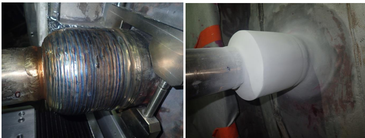
Obr. 4 a obr. 5: Dokončené navařování 8. vrstvy návaru (vlevo) a provedení kapilární kontroly na opracovaném návaru (vpravo)
