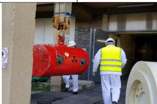
Obr. 5: Transport kontejneru TKS-1000 na měřicí pracoviště
