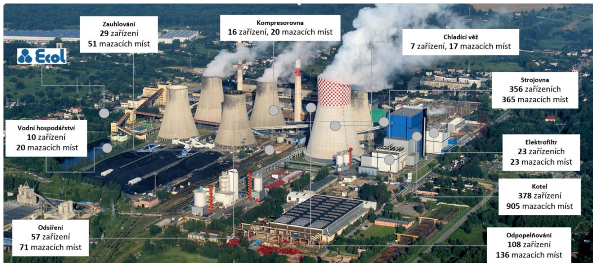
Obr. 1: Lubrication Management v elektrárně s výčtem obsluhovaných mazacích míst
