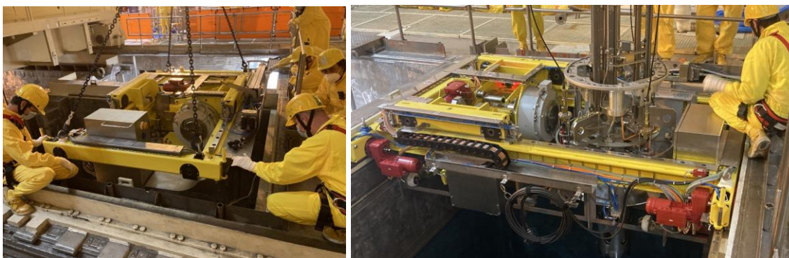
Obr. 4: Vlevo montáž mostu na koleje, vpravo montáž sloupu do mostu SI-PS
