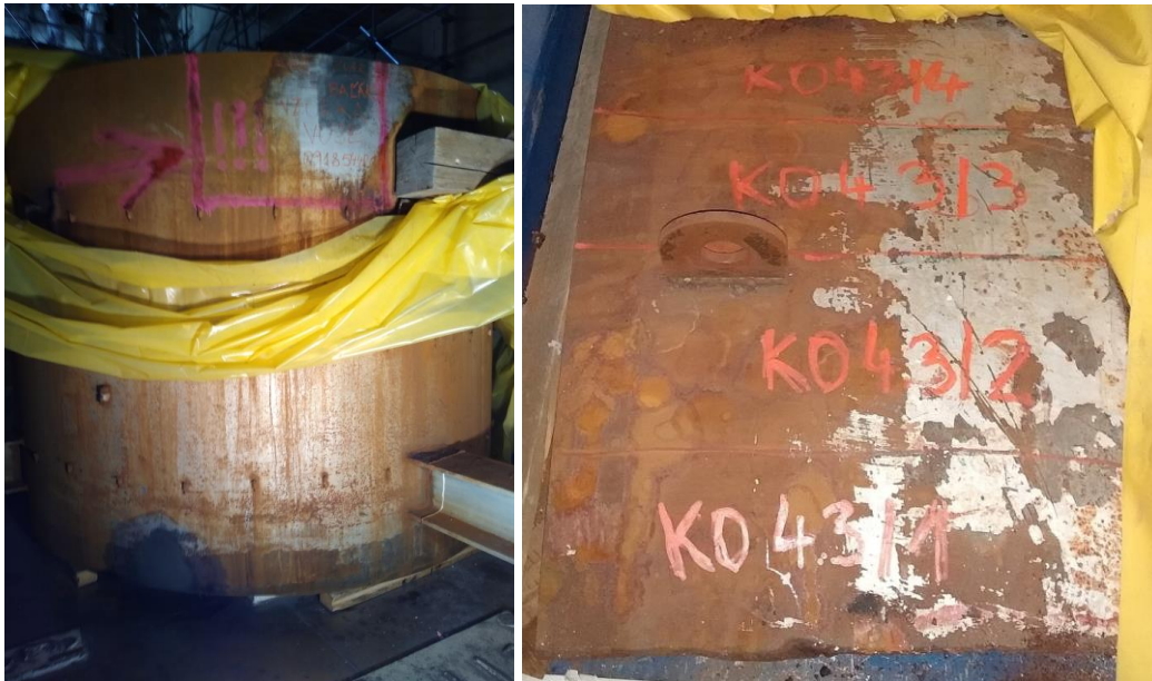
Obr. 3: Fragmentačné pracovisko KO v KP JAVYS a veľkorozmerné fragmenty z plášťa kompenzátora objemu
