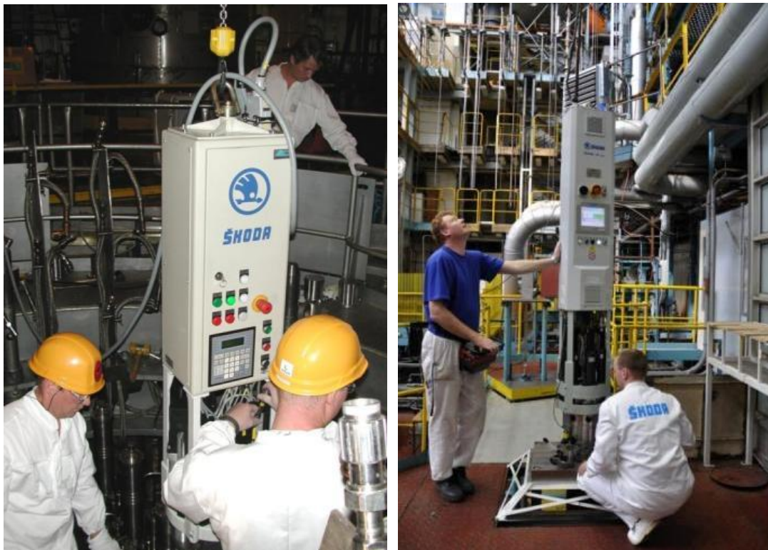
Obr. 1: Vlevo první jednotka EZ650 na JE Loviisa, vpravo nejnovější jednotka EZ340 při stendových zkouškách ve ŠKODA JS a.s.
