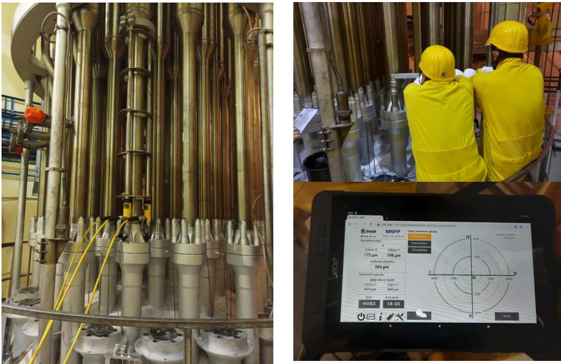
Obr. 2: Vlevo přípravek pro odtrh přírub, vpravo utahování přírub s kontrolou polohy
